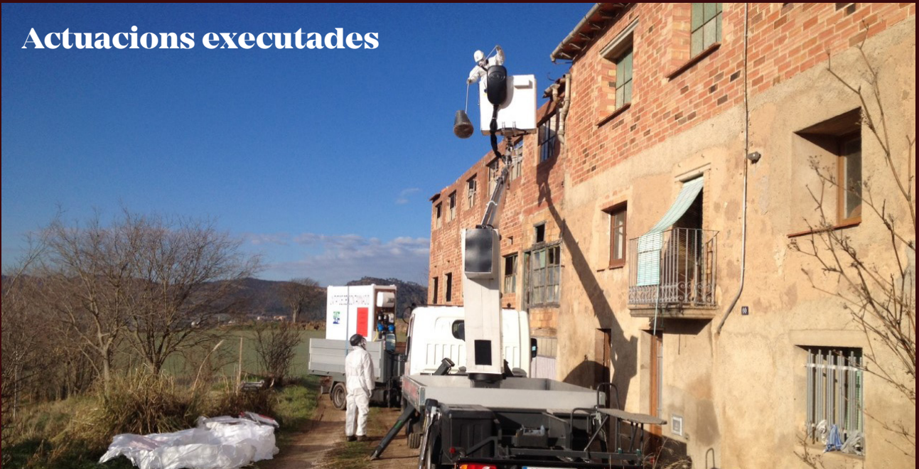
Treballs en una edificació del barri de Segalers
