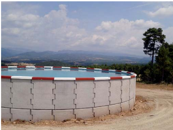
El nou dipòsit contra incendis s'ha instal·lat al barri de Segalers
