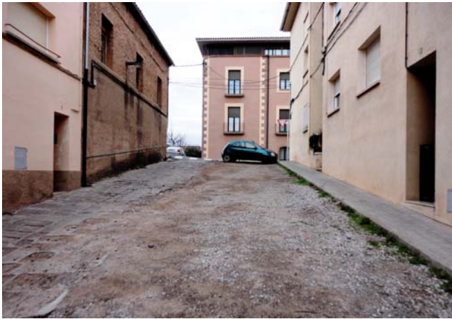
Imatge de l'estat actual del carrer Hospital
