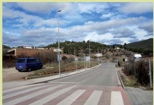
Instal.lació de l'enllumenat públic a l'avinguda Sant Jordi
